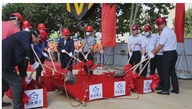
封顶混凝土浇筑
