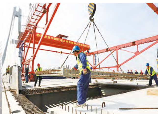
图四、最后一块混凝土预制板吊装
