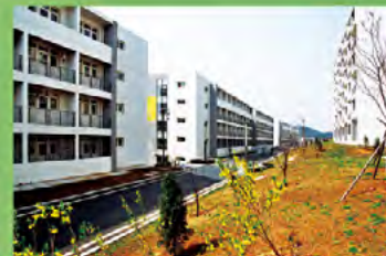
大连医科大学留学生公寓、体育馆、室外体育场
