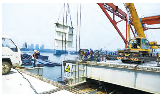
图三、主纵梁吊装施工
