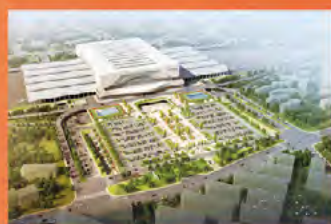
大连北站综合交通枢纽工程
