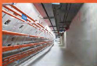
沈阳地下综合管廊 (南运河段) 工程
