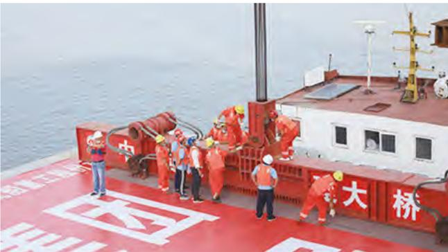
图三、钢箱梁起吊前进行吊机吊具连接
