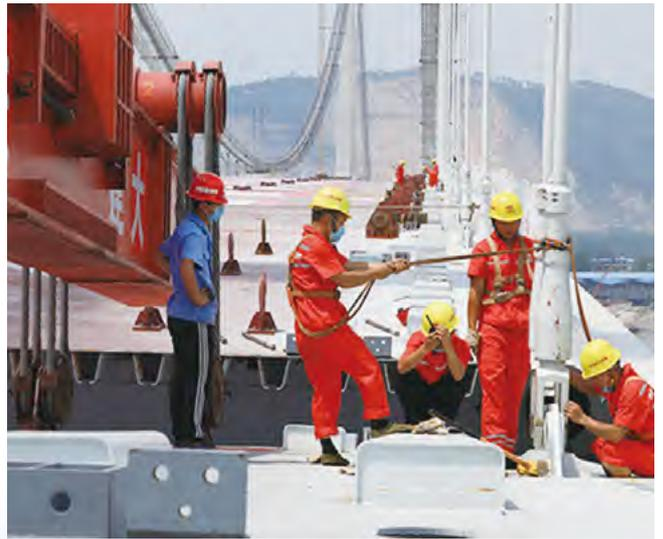
图五、钢箱梁吊升就位后进行吊索与钢箱梁连接安装
