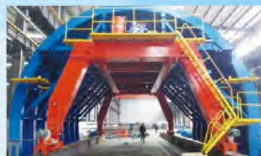
智能二衬浇筑台车施工
