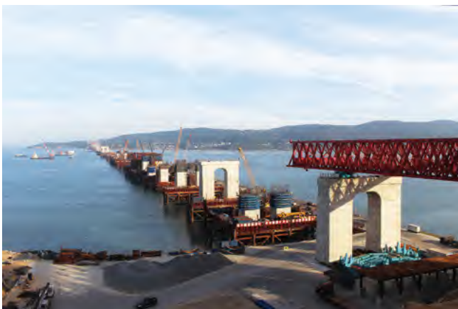
图三、2016年大桥桥墩施工；
