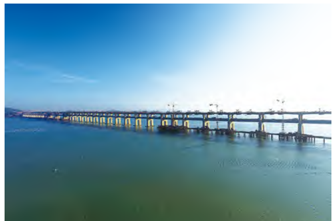
图六、上帝的视角看福平铁路施工现场。
