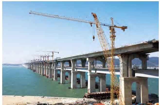
图五、2018年大桥铁路梁和公路梁同时施工；
