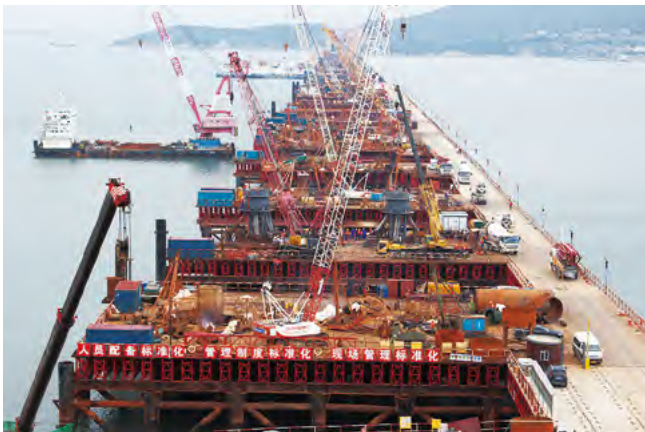
图二、2015年大桥桩基础桩施工；
