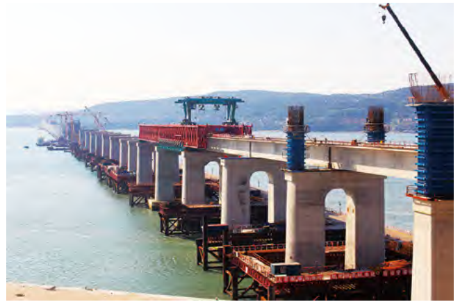
图四、2017年大桥铁路梁和公路墩施工；
