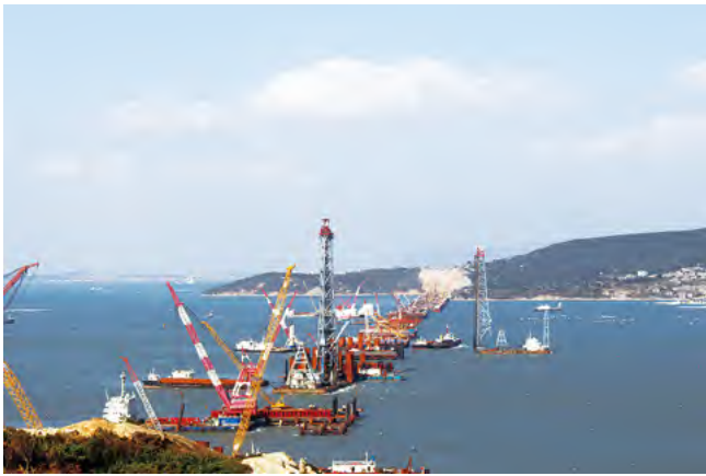
图一、2014年大桥钢便桥施工；
